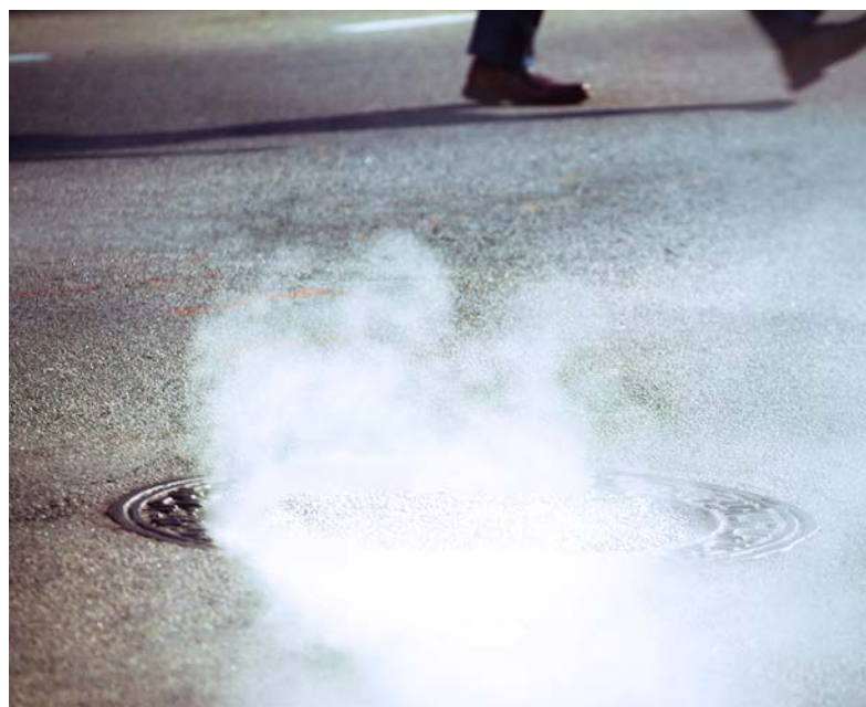
Ungenutztes Wärmepotenzial geht in der Kanalisation verloren.
