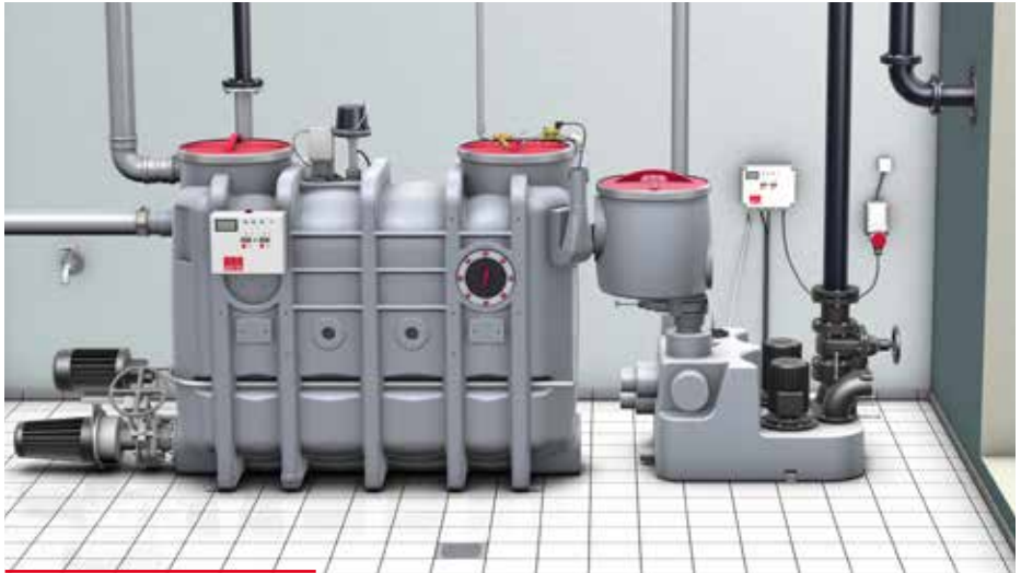
Fettabscheider mit angeschlossener Hebeanlage
