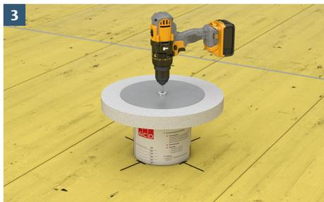
Die Fixierung der ACO Schalungshilfe erfolgt zeitsparend und punktgenau mit den mitgelieferten Befestigungsschrauben auf den Schalungsbrettern.
