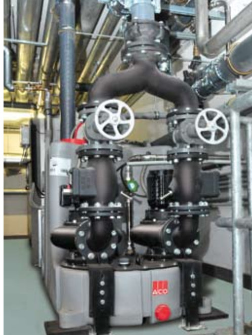
Die ACO Multi-Pro-PE K duo zum Sammeln und automatischen Heben von Abwasser über die Rückstauenebene entspricht der DIN EN 12050-1 (Hebeanlagen für Schwarzwasser). Der Sammelbehälter aus Polypropylen fasst 515 Liter.
