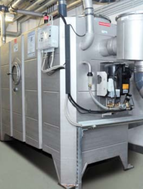
Der ACO Fettabscheider Lipurat-OA (Ausbaustufe 3) aus Edelstahl hat ein Fassungsvermögen von 2.000 Liter. Er verfügt über integrierte Steuerungstechnik mit Fernbedienung. (Direktabsaugung, Reinigung, vollautomatische Befüllung).
