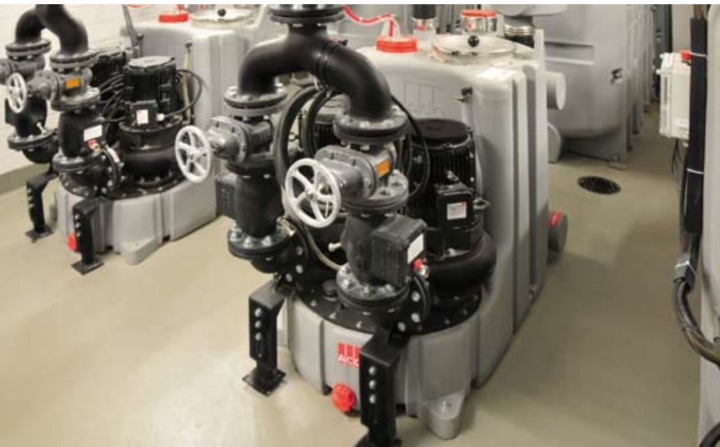
ACO Abwasserhebeanlagen Multi-PE K duo zum Sammeln und automatischen Heben von Abwasser über die Rückstauenebene und ACO Fettabscheideranlagen Hydrojet (im Hintergrund)
