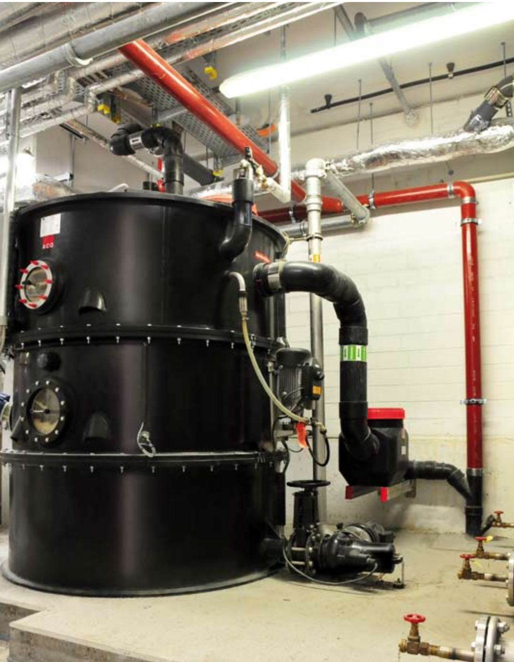
ACO Passavant Fettabscheider Hydrojet aus umweltfreundlichem, recyclingfähigem Polyethylen
